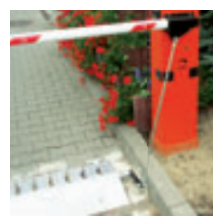
Mechaniczne połączenie kolczatki ze szlabanem.
